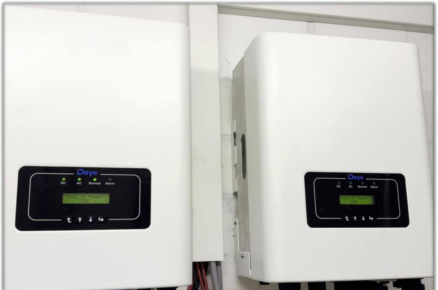
Die beiden Wechselrichter der Volleinspeiseanlage. **Copyright:** Laudeley Betriebstechnik
